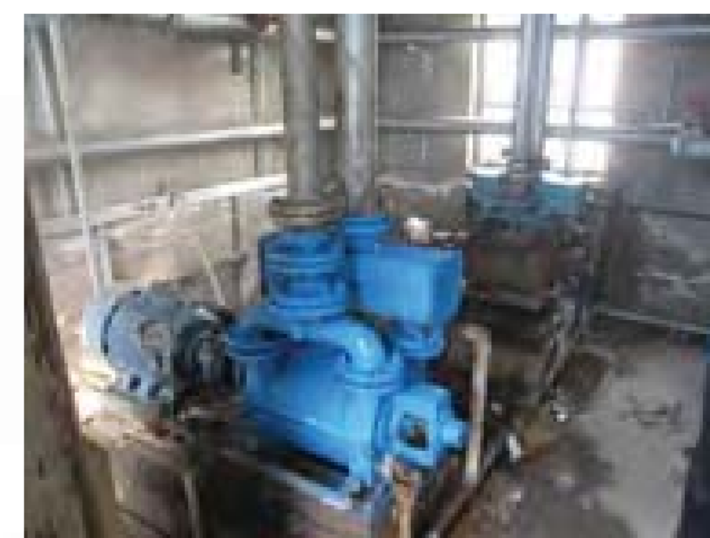
使用水环泵，污水的处理未进入医疗污水处理系统，机房细菌含量超标 《规范》第16页，4.4.8条及第94页相对应条文说明
